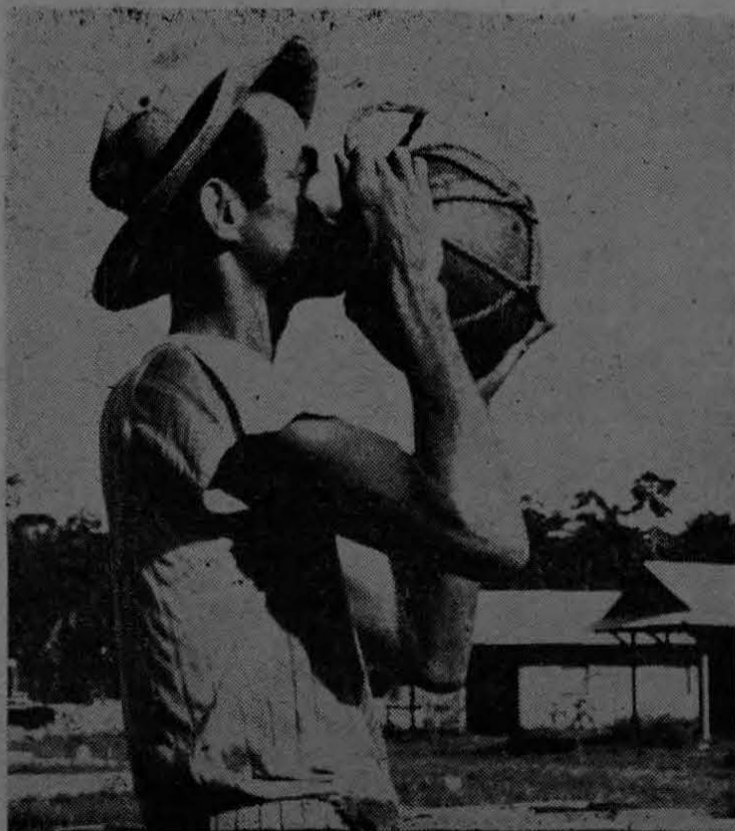
El señor Melito Obando, es otro de los muchos carpinteros que colaboran en la construcción de las nuevas viviendas de la Finca Coto 51. Melito apaga su sed con agua fresca de la típica jicara, tan usada por los obreros de toda la nación.
